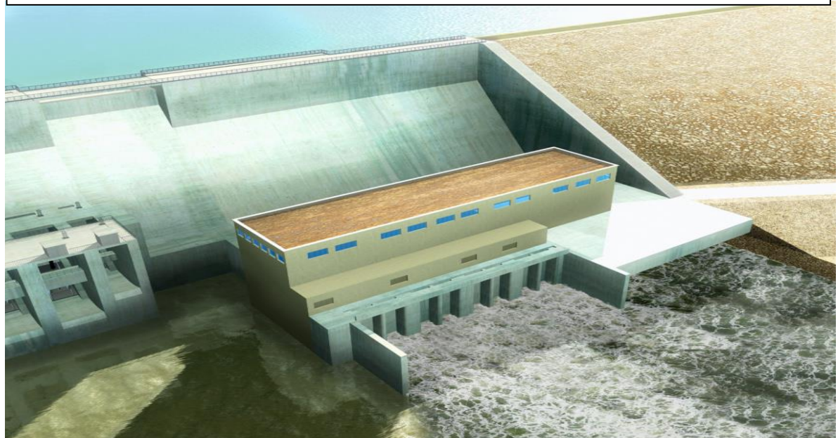
Fig 21 : Le barrage de Lom Pangar
