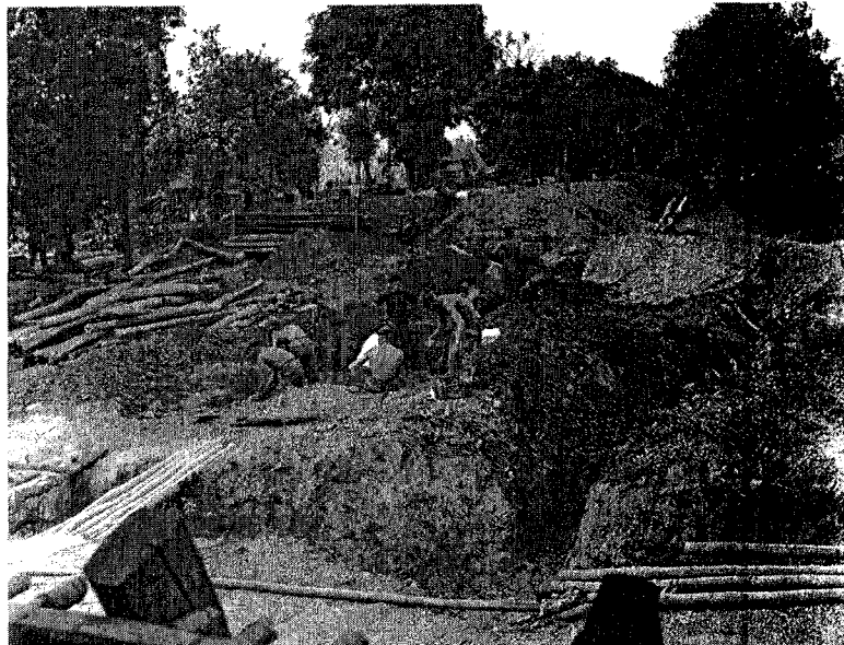
Construction d'un abri peu de temps après CASTOR : la couverture végétale est encore présente, les bois sont d'origine assez disparate : madriers au premier plan, bambou, bois nouveaux au fond. E.C.P.
