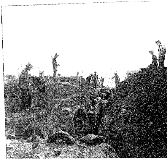
Des P.I.M. au travail sous surveillance à NA SAN. Noter le gabarit de la tranchée . Source : NA SAN GIRAUD-FAVREAU
