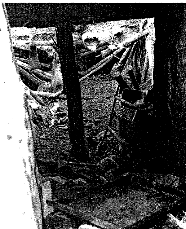
DIEN BIEN PHU : abri détruit dans la deuxième quinzaine de mars . Il est possible de voir des bambous dans les étais effondrés. ECP armées.
