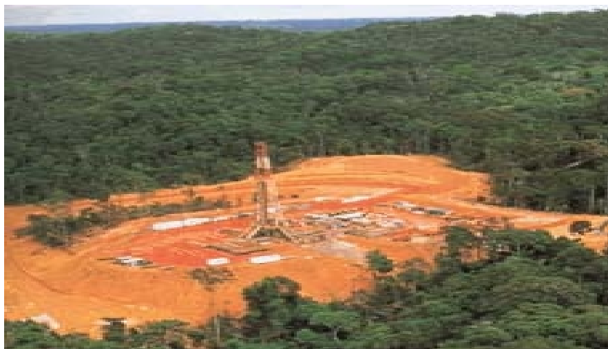
Fig 6 - Forage « on shore »
