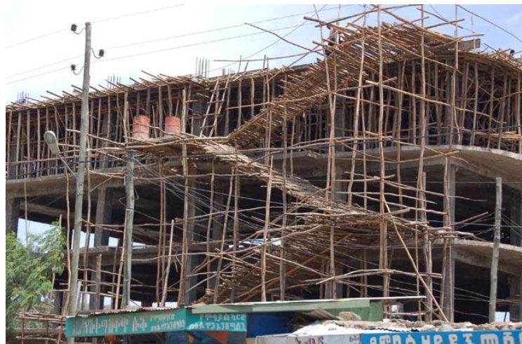
Chantier au cœur d'Addis Abeba
